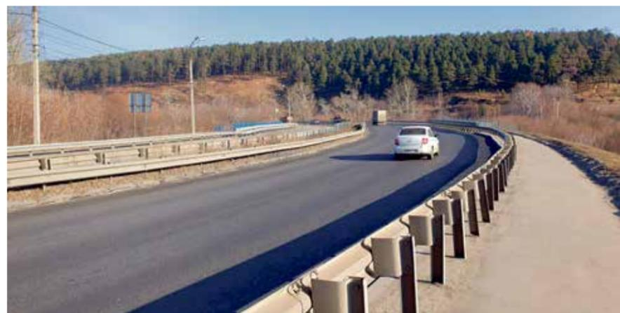
**На мосту через реку Каю дорожники отремонтировали верхнюю сторону (правую, если ехать в сторону центра). Покрытие заменили на 2000 квадратных метров. «Это вторая очередь ремонта моста — первая была выполнена в 2022 году, — объясняют в СЭМ. — Здесь две полосы движения; работы велись без перекрытия проезда — снятие старого слоя асфальта и нанесение нового»**
