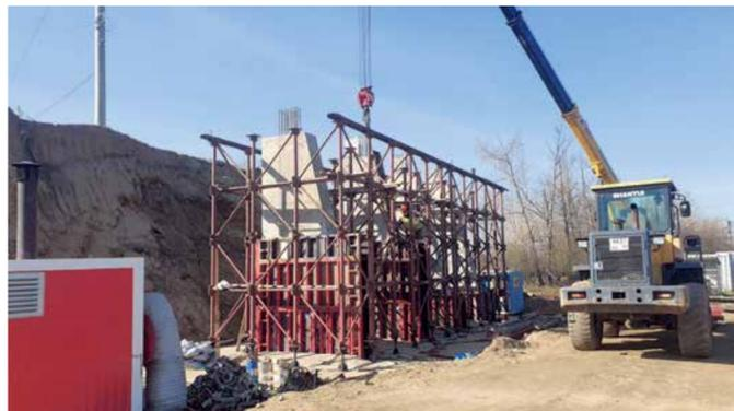
В кадре — первая опора. Строители уже снимают опалубку, которая строилась для заливки бетона: «Необходимое время выдержано, бетон уже набрал прочность. Впереди этап гидроизоляции опор, установка верхних ригелей, после чего начнется обратная засыпка и устройство конуса, который в дальнейшем будет оформлен габионами и матрасами Рено, так же, как на противоположной стороне», — объясняют специалисты
