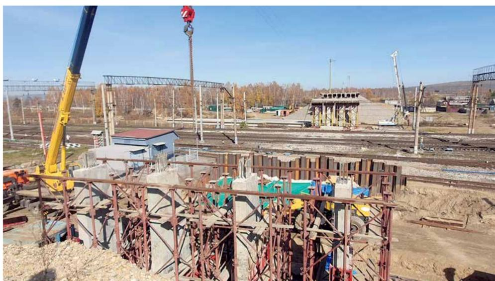
Перспектива будущего путепровода на Батарейной. Этот снимок сделан с подъема, по которому проходила автомобильная дорога, ведущая на демонтированную трассу. На переднем плане — первая опора для нового мостового перехода (бетонные стойки), дальше — металлические шпунты на месте возведения второй опоры (оно уже вовсю идет), на дальнем плане — 7-я опора, конус, оформленный габионами и матрасами Рено (ими укрепляют откосы), и съезд на «правый берег» Батарейной
