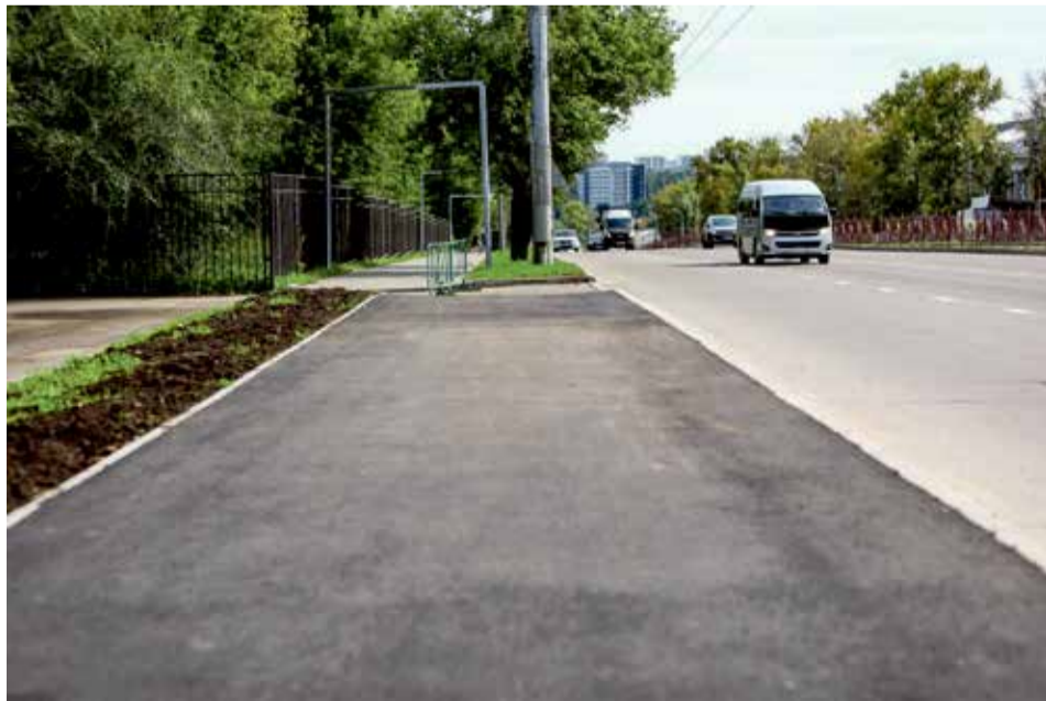
В этом году началось благоустройство от улицы Игошина до Колхозной, напротив ИРНИТУ. Там появились светильники, заменено тротуарное покрытие. «Будут установлены лавочки, урны, информационные стенды, появятся парковки для электросамокатов», — рассказывает Оксана Жучкова
