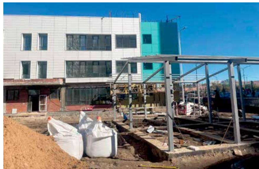
Строительство этого детсада в Нижней Лисихе завершается. Уже закончены работы по устройству железобетонного каркаса, кирпичной кладке стен и перегородок, монтажу оконных блоков. Рабочие провели наружные сети водоснабжения и теплоснабжения, установили бытовую и ливневую канализацию, опоры наружного освещения и подпорные стенки. К открытию детского сада проводится благоустройство прилегающей территории
