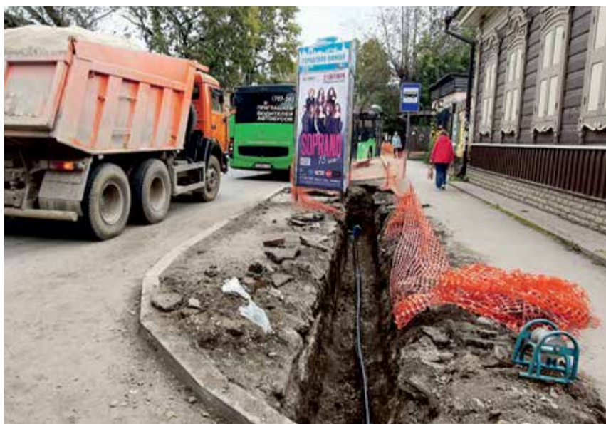
Укладка нового кабель-канала обещает избавить от регулярных перебоев с электричеством жителей «тихого центра» — это улицы Декабрьских Событий, Иосифа Уткина, Фридриха Энгельса, Карла Либкнехта и прилегающих территорий. Уже на днях подрядчик завершит работы на последних 200 метрах из 1300
