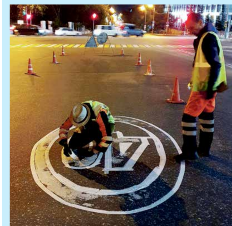
Ночь, улица Маяковского, перекресток с 2-й Железнодорожной. В центре кадра — Вадим Смолкин, один из самых опытных сотрудников ООО «ДМП». В руке Вадима — бумажный малярный скотч, с помощью которого определяются контуры будущей разметки на асфальте
