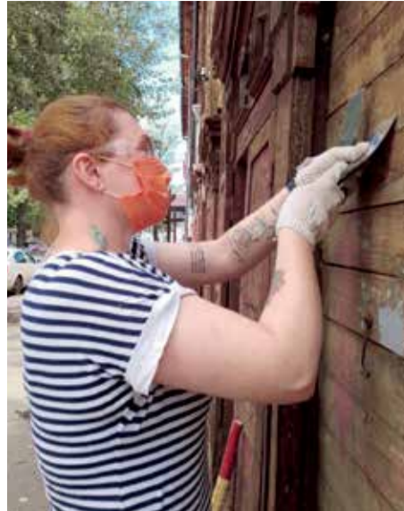
Сначала фасады домов, ставни и наличники очищают от загрязнений и старой краски. Важно в процессе работы не отломить какую-нибудь часть декора у памятника деревянного зодчества, а если что-то все-таки сломалось — передать старшему по дому, чтобы затем специалисты вернули все на место
