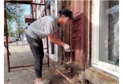
Сначала фасады домов, ставни и наличники очищают от загрязнений и старой краски. Важно в процессе работы не отломить какую-нибудь часть декора у памятника деревянного зодчества, а если что-то все-таки сломалось — передать старшему по дому, чтобы затем специалисты вернули все на место
