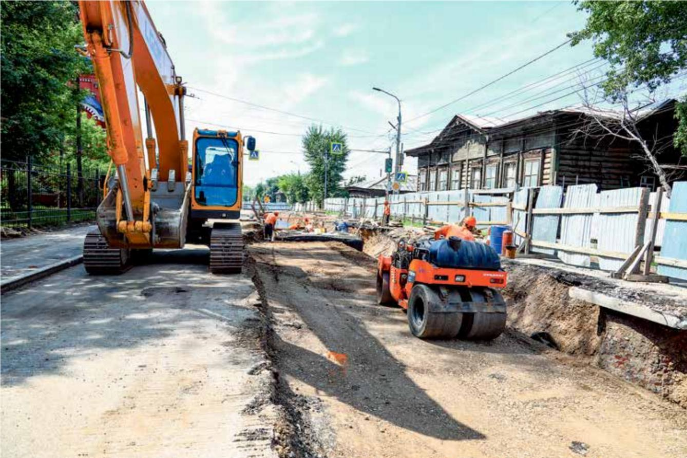
На строительстве теплового луча завершают работу на двух участках на улице Баррикад. Возле Казанской церкви сейчас трамбуют грунт при помощи виброкатка в ранее вырытой траншее: трубы теплового луча, который принесет тепло и горячую воду в эту часть Иркутска уже под землей. Это сложная работа двух машин — катка и экскаватора: экскаваторщик одновременно подсыпает грунт, куда это требуется
