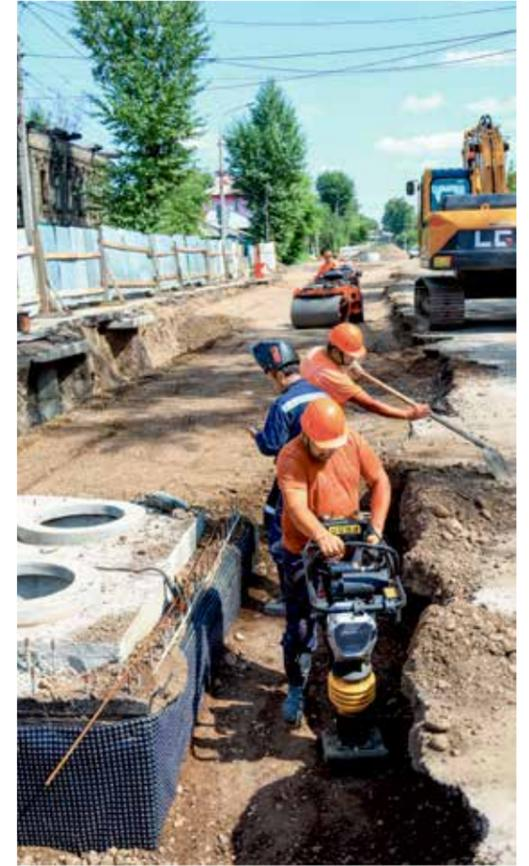
А на этом участке улицы Баррикад грунт трамбуют вручную: это более тщательная работа в траншее будущего теплового луча, потому что здесь на поверхность выведены колодцы
