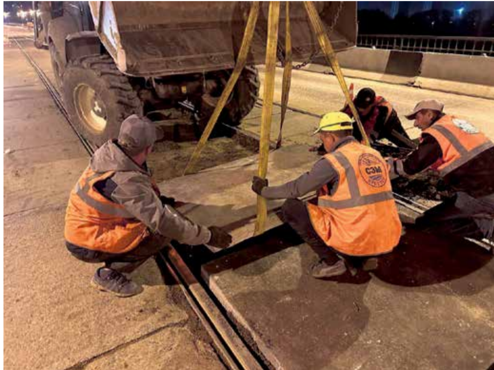
Ночь. Улица. Глазковский мост. Сотрудники муниципального предприятия «Служба эксплуатации мостов» меняют плиты, пока город спит. Сначала выравнивают основание отсевом, а затем уже опускают 300-килограммовую бетонную плиту на ее законное место. Специалисты говорят, что такие плиты комфортны для автомобилей и безопасны для трамваев
