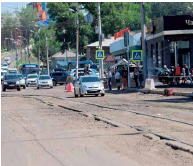
Участок Байкальской, упирающийся в район Центрального рынка, сейчас переживает активную фазу комплексного ремонта. После него здесь все будет новым: асфальт (больше 7 тысяч квадратных метров тротуаров и 10 тысяч — дороги), бордюры, ливневка, «лежащие полицейские», светофоры, дорожные знаки, урны, скамейки, остановки, ограждения. И закончится ремонт, как водится, озеленением (посадят деревья и кустарники)
