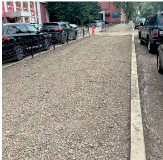
Комплексный ремонт на улице Горького в самом разгаре: почти везде демонтированы старые тротуары, рабочие готовят основание для новых, устанавливают гранитные (!) бордюры. Происходящее радует нас, сотрудников «Иркутска», не меньше, чем жителей окрестных домов или тех, кто часто бывает в центре города по делам: именно на Горького находится наша редакция. «Наберитесь терпения», — говорят нам дорожники. Да с удовольствием — не вопрос!
