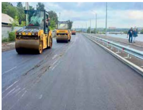
«Летом прошлого года был проведен капитальный ремонт улицы Верхняя Набережная. Там сделали насыпь из скального грунта и укрепили откосы, обустроили широкие тротуары и велодорожку, установили ограждения», — рассказывает Александр Друзенко об одном из самых масштабных проектов на территории своего избирательного округа. И добавляет: «Поскольку сама набережная — любимое место прогулок у горожан, есть инициатива дать ей оригинальное название!»
