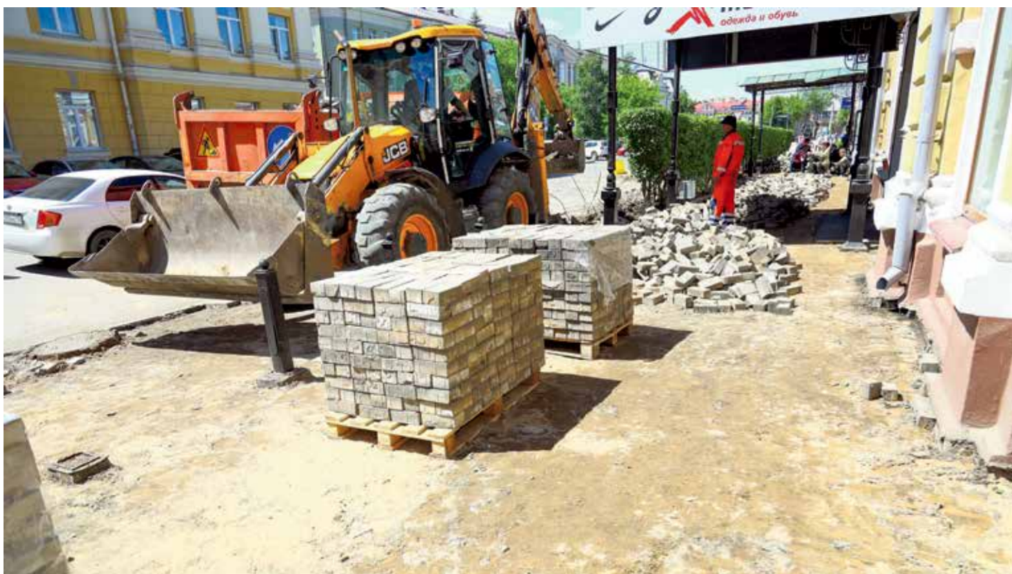
Плитку на тротуарах на улице Пролетарской в центре Иркутска демонтируют, потому что горожане недовольны ее безопасностью: что летом во время дождя, что зимой ходить по ней оказалось скользко. Здесь будет уложен привычный всем асфальт. А вместо бетонных бордюров устанавливают гранитные. «Эти простоят не один десяток лет», — говорят рабочие, которые оформляют Пролетарскую в гранит. «Сопромат учили? Нет? Смотрите, какой материал твердый, ему сносу не будет!» — ловко орудуя пилой, снисходительно делятся знаниями дорожники
