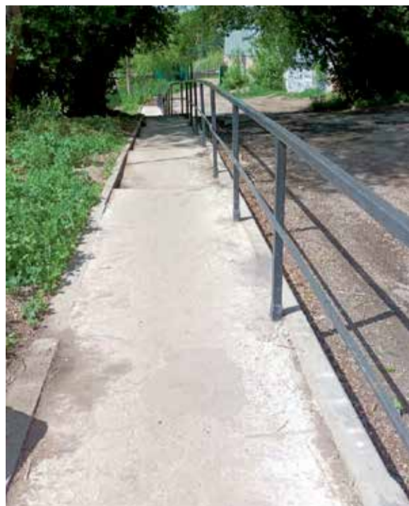
Эту лестницу в районе улицы Помяловского обустроили почти три года назад за счет «депутатского фонда». Но потом засорился сток, и вода перестала уходить с лестницы, из-за чего у людей возникали проблемы. В настоящее время ливневка очищена
