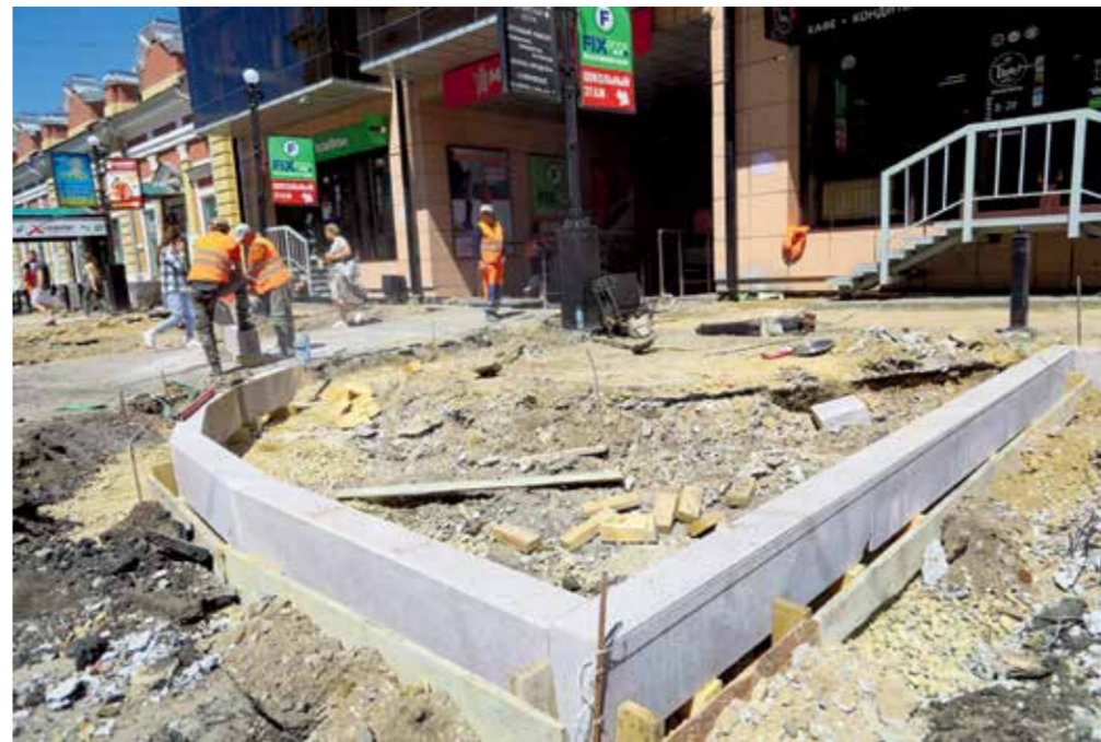
Уже ясны очертания будущего тротуара возле парковки у торгового центра «Сезон», а бортовой камень из гранита даже сейчас, еще до асфальтирования, выглядит солидно, внушительно. Кстати, парковку здесь расширят: после ремонта она сможет вместить 15 автомобилей. Те читатели «Иркутска», кто часто бывает в этом районе, знают, что раньше машины «заступали» на проезжую часть, перекрывая обзор тем, кто ехал по Пролетарской
