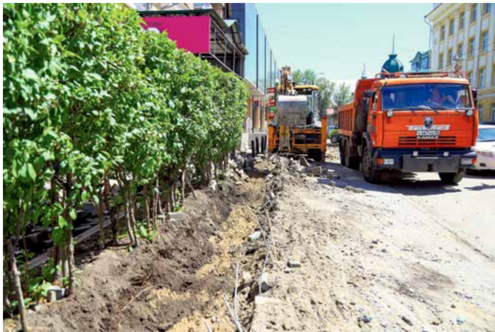
Сейчас Пролетарская переживает самую драматичную стадию работ: вскрывается асфальт, демонтируются старые тротуары. Но закончить все планируется уже к концу июля. Надо потерпеть немного, и мы увидим около 600 новых метров дороги в этой исторической части города. А после, как водится, сделают современное освещение, проведут озеленение, установят пешеходные ограждения и тактильную плитку
