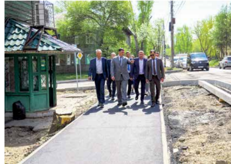
Небольшая, тенистая и очень уютная улица Чайковского на левом берегу переживает сейчас комплексный ремонт дороги. Начиная от пересечения с Маяковского и заканчивая перекрестком с Терешковой (которую обновили в 2019 и 2023 годах) улица приобретает новые тротуары, асфальт и всю остальную дорожную «амуницию», положенную по правилам плана федерального проекта «Безопасные качественные дороги». Именно об этом говорят шагающие по свежеему асфальту тротуара (слева направо) Антон Медков, глава Свердловского округа, Руслан Болотов, мэр Иркутска, Василий Ефремов, руководитель «Иркутскавтодора», и Сергей Тен, депутат Государственной Думы
