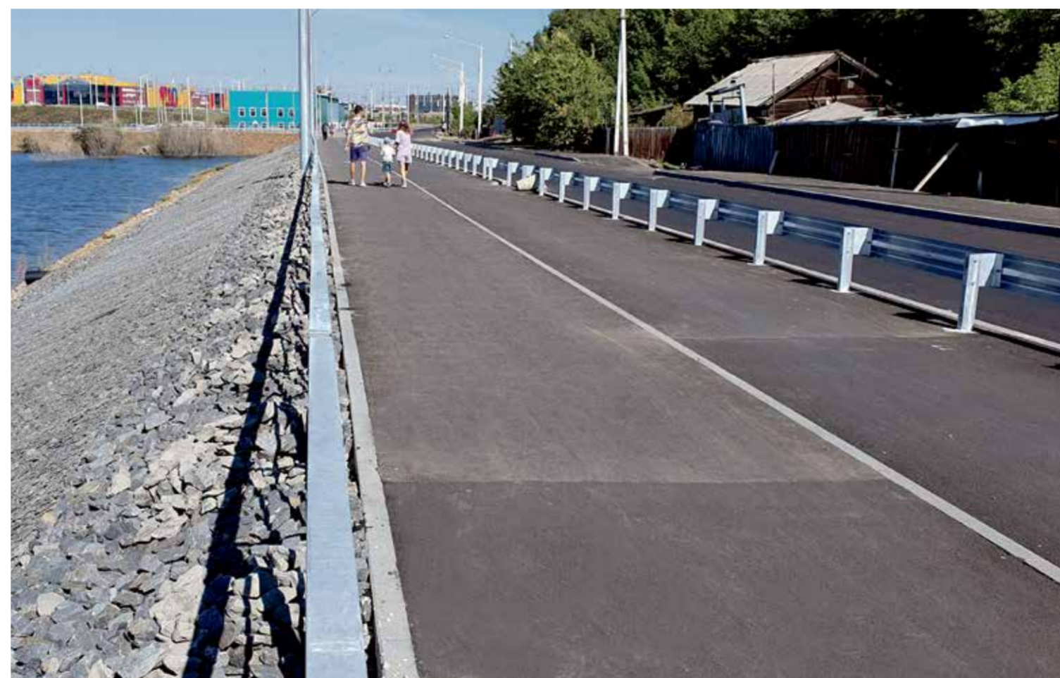
Участок дороги от дома № 107 на Верхней Набережной до развязки Академического моста в 2023 году стал объектом масштабной реконструкции: здесь выполнено переустройство электрических сетей, наружного освещения, а также септы водоснабжения; укреплены откосы, устроены ливневая канализация и приемный резервуар. Полностью отремонтирована проезжая часть, металлическим ограждением от дороги отделены велодорожка и тротуар. Еще один тротуар построен вдоль жилых частных домов
