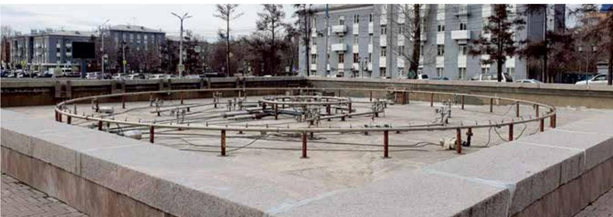
Сотрудники «Водоканала» напоминают, что забираться в чаши фонтанов опасно для жизни (!) — во многих из них проложены электрические кабели. Часть их питает двигатели, подающие воду под напором в системы, другие обеспечивают работу освещения. Конечно, все сделано так, чтобы не подвергать опасности жизни горожан, однако и испытывать судьбу не рекомендуется
