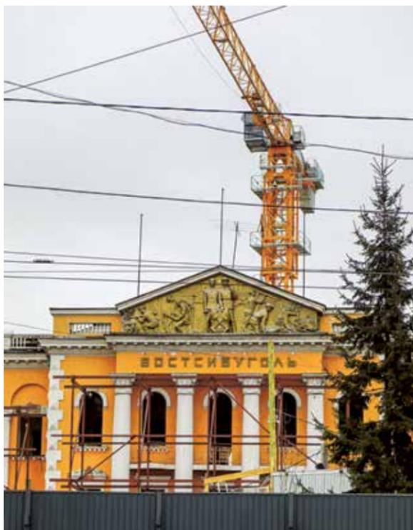
Над «Востсибуглем» уже почти год выстится башня крана, а минувшим летом здание обнесли строительным забором. После реконструкции (предполагается, что она займет три года) появится еще один этаж — четвертый, вернется на место уже демонтированные башни. Разумеется, проект предусматривает усиление конструкции здания: на стройплощадке применили устройство буросекущих свай — специальный метод для укрепления фундаментов зданий и сооружений, расположенных в районах с плотной застройкой
