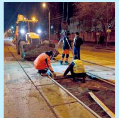
**Сначала рабочие «Иркутскавтодора» выравнивают основание отсевом, а затем уже опускают 300-килограммовую бетонную плиту на ее законное место. Специалисты говорят, что такие плиты комфортны для автомобилей и безопасны для трамваев**
