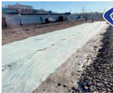
Началось обустройство временной дороги в объезд строительства теплового луча и места реконструкции канализации на участке от Маратовской развязки до улицы Фридриха Энгельса. Сотрудники муниципального «Иркутск-автотрасса» укладывают нижний слой будущего обхода щебнем
