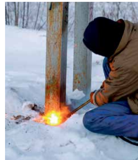
Чтобы демонтировать билборд, нужна определенная сноровка. На наших глазах буквально за три минуты специалист с помощью сварки срезал железный столб, на котором крепится стэнд с рекламным баннером
