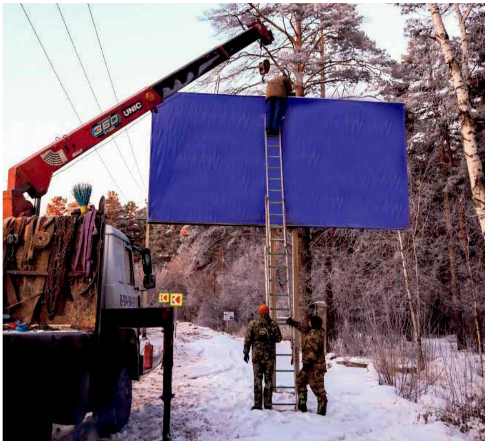
Репортерская группа «Иркутска» вместе с сотрудниками администрации города недавно участвовала в демонтаже незаконной рекламной конструкции на улице Маяковского. Можно сказать, нам повезло: чаще всего снос происходит по ночам, чтобы не мешать дорожному движению — в основном билборды размещают вдоль автомобильных дорог. На снимке вы видите первый этап: рабочий закрепляет блок подъемного крана на баннере (рекламное изображение удалил дизайнер «Иркутска» во избежание нарушения закона «О рекламе»)
