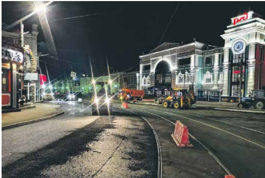
Ремонт улицы Терешковой от железнодорожного вокзала до места, где был кинотеатр «Чайка», начался весной этого года. Подрядная организация — муниципальный «Иркутскавтодор» — ремонтирует дорожное полотно и тротуары, восстанавливает бордюры и лестницы, ливневую канализацию и освещение. Кроме того, на Терешковой выполняют косметический ремонт подпорных стен и ремонт покрытия межрельсового пространства трамвайных путей
