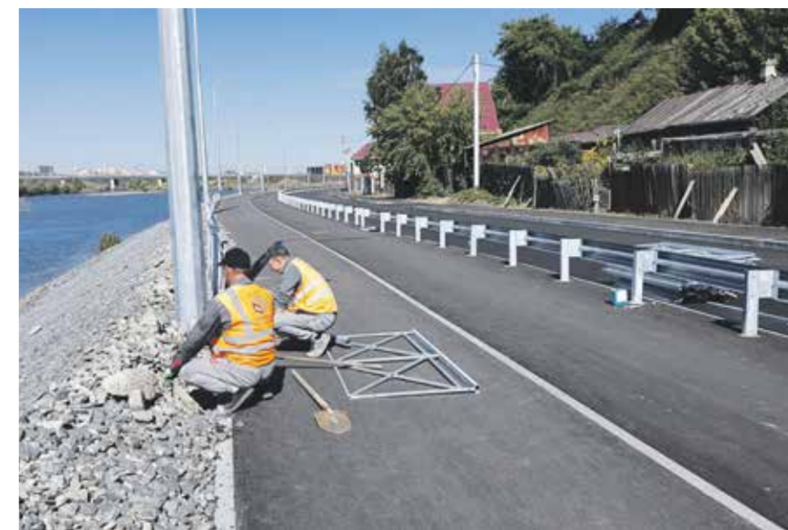
Участок дороги от дома 107 на Верхней Набережной до развязки Академического моста подвергся масштабной реконструкции: здесь выполнено переустройство электрических сетей, наружного освещения, а также сетей водоснабжения; укреплены откосы, устроены ливневая канализация и приемный резервуар. Полностью отремонтирована проезжая часть, металлическим ограждением от дороги отделены велодорожка и тротуар. Еще один тротуар построен вдоль жилых частных домов. Сейчас строители завершают монтаж изгороди в пешеходной зоне, впереди — нанесение разметки и запуск движения
