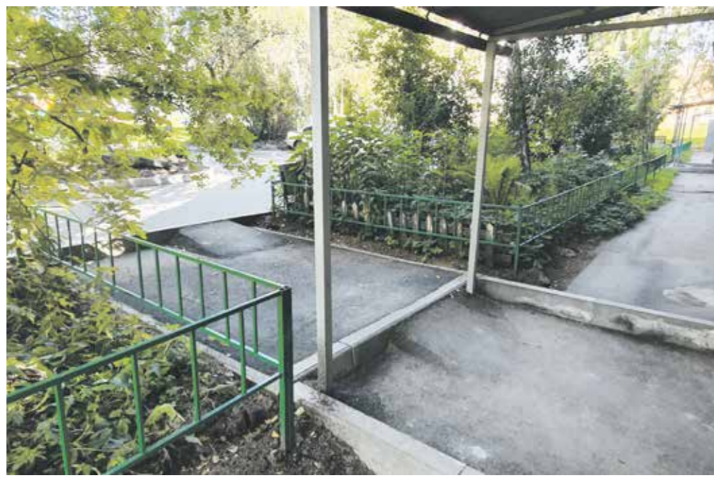
Это выход из одного из подъездов 151-го дома на улице Карла Либкнехта. Видно, что подъем выполнен ступенчато, и от проезжей части он отделен бордюром камнем. Сделано это для того, чтобы уберечь жителей от стоков воды во время дождя или таяния снега. А для колясок или чемоданов строители устроили аккуратные пандусы
