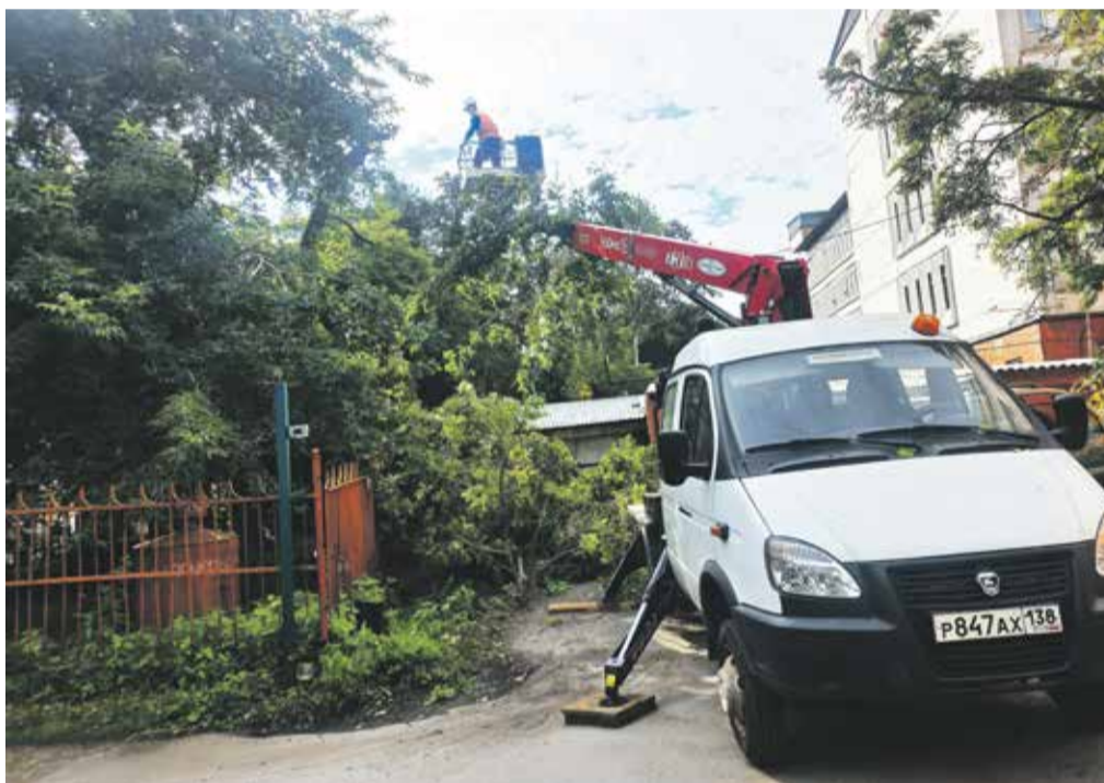
На фото — момент, когда во дворе дома на улице Марата, № 62/2 сносят старый клен. Видите газовую установку на переднем плане? Жителей беспокоило, что огромное дерево с «высокой парусностью» однажды рухнет на нее. После демонтажа всю древесину убирают и вывозят — рано утром или по вечерам, чтобы не загружать дороги. Кстати, на это подрядным организациям дается 24 часа
