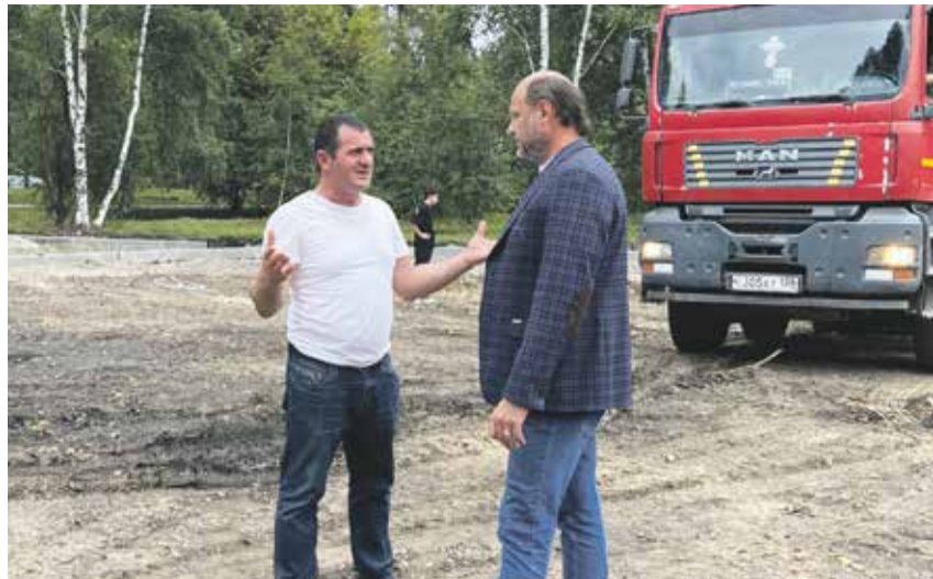
На фото — депутат Ростислав Белых на месте будущего парка в Приморском округе обсуждает с сотрудником подрядной организации ход работ по благоустройству: Ростислав Викторович постоянно следит за процессом. Здесь планируется построить хоккейный корт, оборудовать несколько игровых пространств, тренажерную площадку, скейт-парк, обустроить тропиночную сеть со скамейками и урнами, а также установить камеры видеонаблюдения
