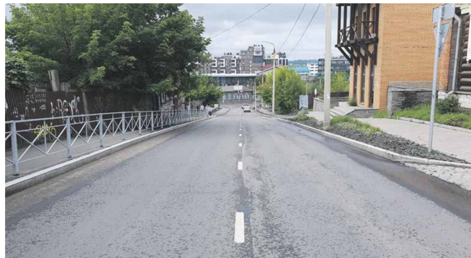
Такой увидели обновленную улицу Кожова представители приемной комиссии. Процесс осмотра отремонтированных улиц проходит в несколько этапов с выездами различных служб на объект — каждое ведомство следит за своим направлением, в том числе Водоканал, теплосети, службы связи, ГИБДД и др. Всякий раз подрядная организация получает замечания от членов комиссии, и только после окончательной доработки объект считается сданным, а компания, выполнившая ремонт, получает оплату. Кстати, гарантия на асфальтобетонное покрытие — четыре года
