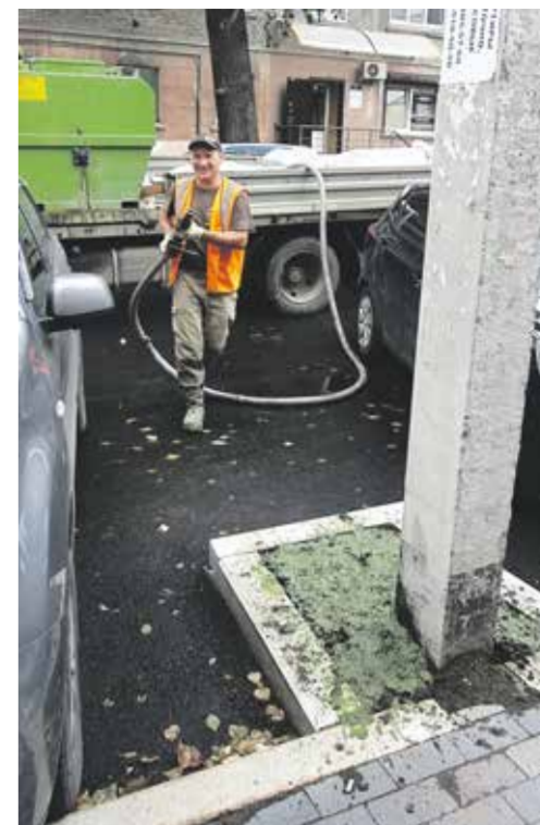
На фото — сотрудник компании «Техдорстрой» и устройство газона методом гидропосева на улице Киевской. На плодородный слой наносится состав, в который входят вода, семена растений, удобрения, стимуляторы. Комплекс распределяется равномерным слоем по выровненной поверхности. Дальше — полив и ожидание всходов
