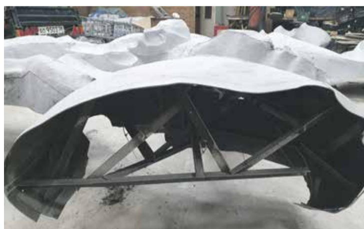
Горельеф полностью выполнен из алюминия, включая каркасную сетку из уголков того же металла. Состояние материала, несмотря на 46-летний возраст, близко к идеальному — алюминий не подвержен коррозии, а значит, прослужит еще десятки лет
