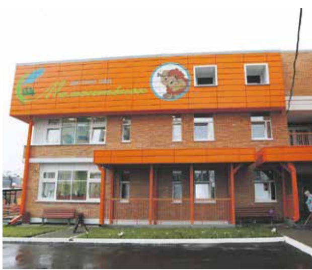
В каждую группу «Мамонтенка» организован отдельный вход, в раздевалке есть сушильные шкафы для одежды, в игровых комнатах установлены проекторы и интерактивные доски. И все это очень хорошо охраняется: на всей территории установлено наружное видеонаблюдение, кодовые замки, на спецпосту круглосуточно дежурит охрана.
