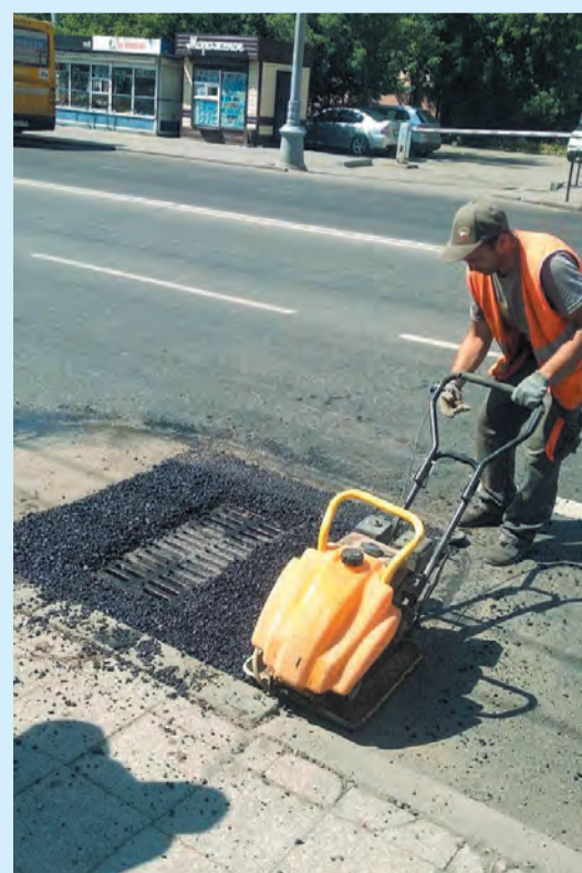
Чтобы решетки и люки колодцев ливневой канализации не выступали за пределы дорожного полотна, специалисты муниципального предприятия «Иркутскавтодор» регулируют их положение по высоте. Работы по ремонту колодцев сейчас идут во всех районах города
