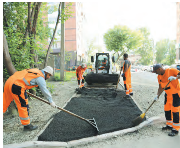
На улице Зверева асфальтируют тротуары (на фото). В ближайшее время, по заверениям подрядчика, приступят к укладке покрытия на проезжей части. На улице Трилиссера в этом году обновляют больше километра дорожного полотна. А главное — на всем протяжении здесь сделали широкие и удобные тротуары, которые не одно десятилетие были в разрушенном состоянии
