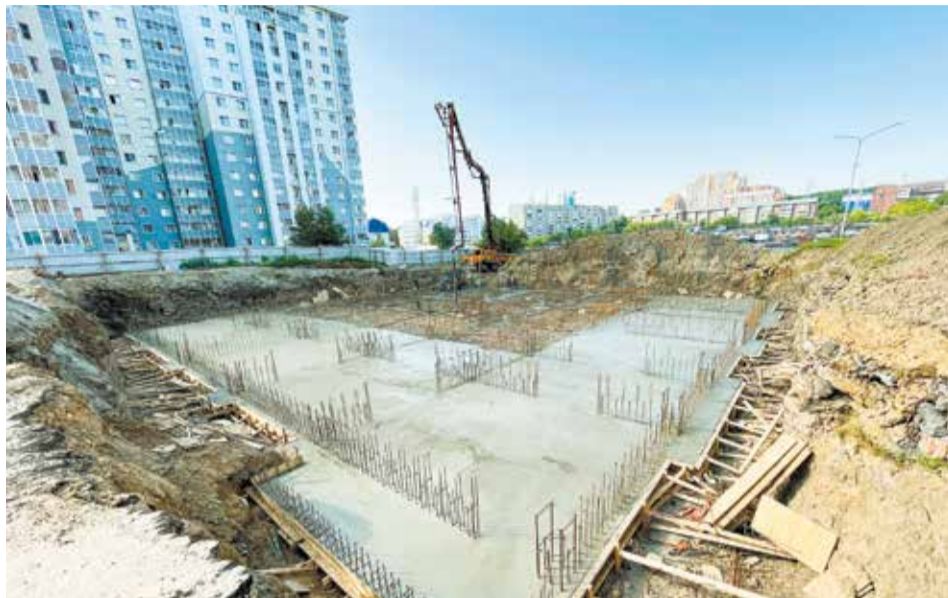
Начало строительства всегда потрясает своими масштабами: котлован, сваи, армирование будущего фундамента. На фото — детский сад для 150 маленьких иркутян, который строится в микрорайоне Нижняя Лисиха на участке недалеко от плотины ГЭС, рядом с улицей Верхняя Набережная. После возведения здания городская власть приведет в порядок дорогу возле детского садика
