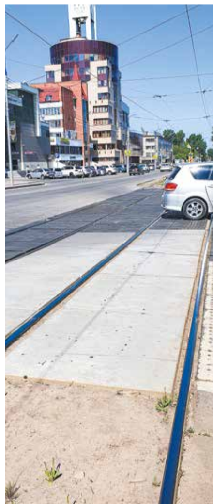
Этот снимок сделан на перекрестке улиц Декабрьских Событий и Трудовых Резервов. Здесь резиновое покрытие частично заменили в начале мая, и это уже оценили и прохожие, и автомобилисты. По словам специалистов «Иркутскавтодора», гарантийный срок службы у новых бетонных плит — три года
