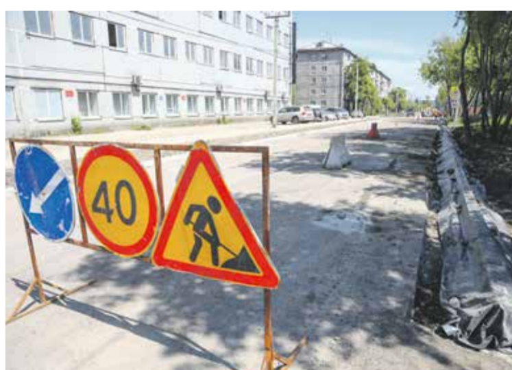
Улица Марии Ульяновой в Иркутске II восстанавливается по программе «Безопасные качественные дороги». Здесь полностью меняют дорожное полотно, тротуары, бордюры, остановочный павильон, проводят переустройство колодцев. По словам мэра Иркутска Руслана Болотова, подрядчик взял хороший темп. Уже демонтировано покрытие на проезжей части, делается основание тротуаров, устанавливаются бордюры
