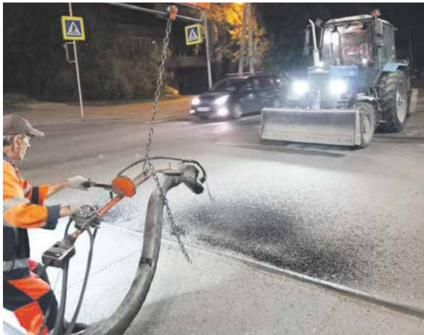
На фото — по ночам на улицах Иркутска работает, латающая дорожные дефекты после зимне-весеннего сезона, специализированная машина БЦМ. Она представляет собой эффективный и недорогой вариант дорожной техники, которая способна быстро, с минимальными затратами и весьма качественно справиться с задачами ямочного ремонта
