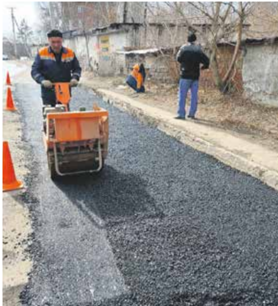
Ремонт большими картами является эффективным и надежным способом восстановления дорожного полотна, и его используют во всех районах города на разрушенных участках дорог. Уже сегодня проводятся эти ремонтные работы. К примеру, вот процесс укладки большими картами асфальта на улице Геологов
