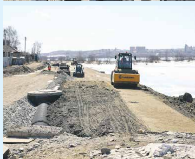
Глава города Руслан Болотов со своими «коллегами на один день» — Станиславом Руновичем и Николаем Бражниковым, участниками проекта #вместесМэром, проверил, как идет капитальный ремонт улицы Верхняя Набережная, который выполняют по национальному проекту «Безопасные качественные дороги». Сейчас на объекте ведут устройство колодцев ливневой канализации, прокладывают водопроводные трубы. Подрядная организация готовится к отсыпке земляного полотна до проектных отметок с последующим устройством основания дорожной одежды. Завершить ремонт должны в этом году
