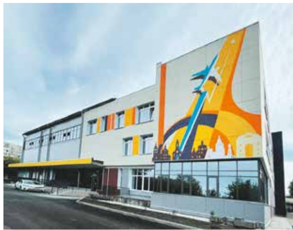
Новенький блок начальной школы № 14 на улице Карла Либкнехта распахнул двери для ребятни 1 сентября уходящего года. 2022-й был удачным для Иркутска в плане строительства социальных объектов. 2023-й, убежден Руслан Болотов, продолжит эту позитивную тенденцию: наряду с завершением возведения отдельных учебных блоков школ № 53, 57 и 75, продолжением строительства учебного заведения на улице Багратиона и реконструкции бывшего кинотеатра «Марат» в 2023 году предусмотрено начало проектирования еще ряда учреждений
