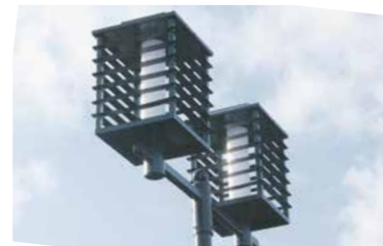
Эти светильники заслуживают отдельного рассказа. Дело в том, что изготовлены они в нашем городе по уникальному эскизу архитектора Сергея Демкова и подобных больше нет нигде (даже в других районах Иркутска). В 2021 году эти светильники установили на верхнем ярусе набережной, а в этом — на нижнем. Всего на променаде появилось 65 новых светодиодных фонарей (высотой в 3,5 метра) со 130 светильниками, в результате чего посещение Нижней набережной стало комфортным не только днем, но и вечером
