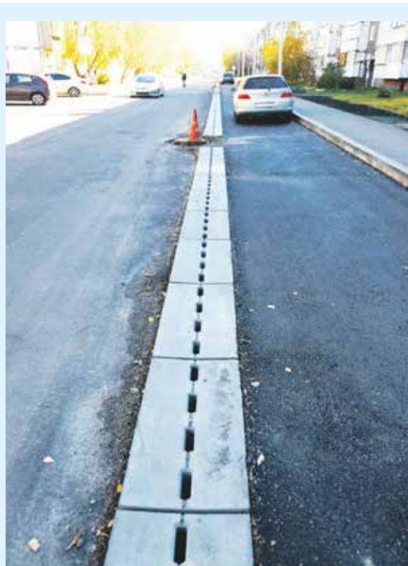
Так выглядит первая на сегодняшний день в Иркутске ливневая канализация последнего поколения. Ее обустроили на улице Волгоградской в Ленинском округе. Под этими решетками — сборные лотки, в которые стекает вода. Через каждые 30 метров — смотровые окна, периодически их будут открывать и при помощи машин для прочистки труб, так называемых кротов, чистить. Если эта система покажет свою целесообразность, такие ливневки будут устанавливать и на других улицах города
