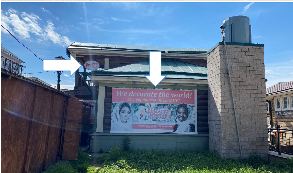
Перечень информационных конструкций, подлежащих демонтажу в добровольном порядке
