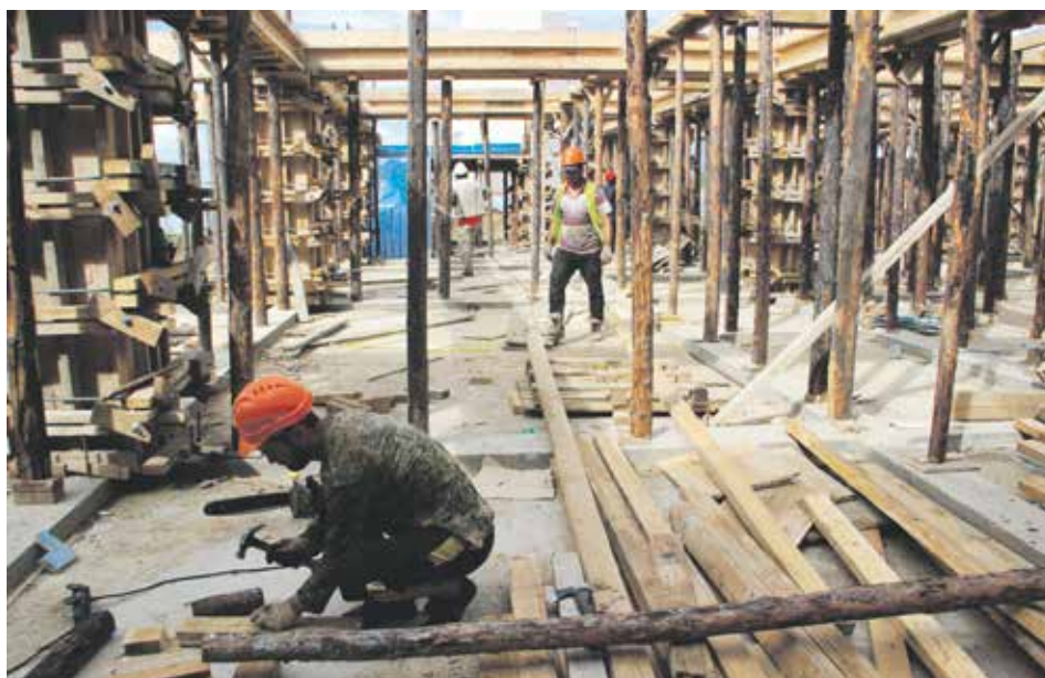
Двухэтажный детский сад в шестом микрорайоне Ново-Ленино на 220 мест начали строить в ноябре 2021-го. Сдать его в эксплуатацию запланировано в конце года, поэтому работа ведется ускоренными темпами. Учреждение будет максимально комфортным для воспитанников — с бассейном, спортивным и актовым залами, площадки для прогулок оборудуют тентовыми навесами, кроме того, обустроят отдельную большую спортивную площадку
