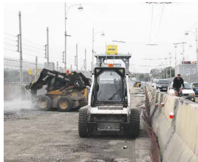
Ремонт дороги на Иркутской ГЭС подрядчики En+ Group занимают круглосуточно. Рабочие выходят в восемь утра и работают до восьми вечера, затем их сменяет бригада, которая занимается реконструкцией трассы всю ночь до восьми утра. Всего на объекте задействовано 20 человек и четыре мини-погрузчика, два самосвала. Рабочие трудятся при любых погодных условиях, даже в грозу и ливень — под специальными навесами
