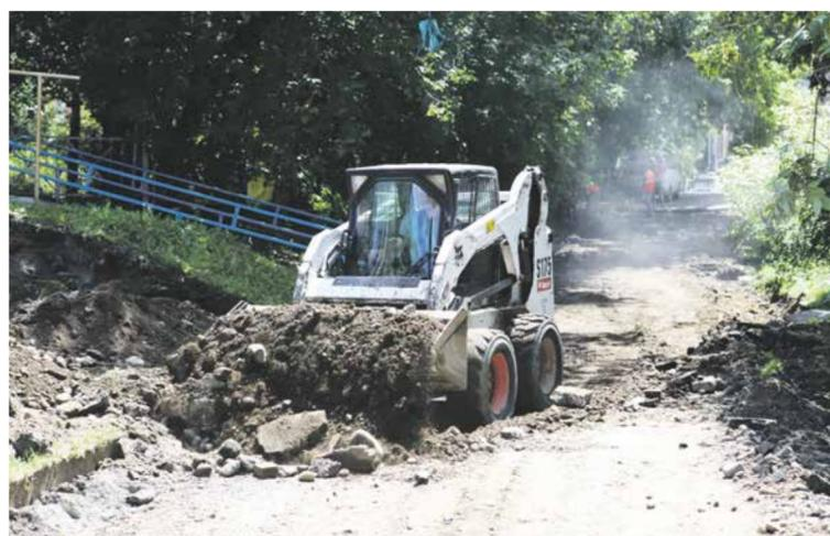
К обустройству двора у многоквартирного дома № 61 на улице Александра Невского приступили на прошлой неделе. Сейчас работы выполнены на 15 процентов: демонтировано асфальтовое покрытие проезжей части, проводится установка бортовых камней. В ближайшее время подрядной организации предстоит заасфальтировать проезд, расширить автопарковку, укрепить склоны геосинтетической сеткой
