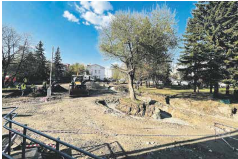
Так сейчас выглядит сквер у театра кукол «Аистенок»: полным ходом идет его реконструкция. Уже демонтировали кирпичные подпорные стенки клумб и старое освещение. В сквере появятся новый асфальт, скамейки, там проведут озеленение и заменят освещение
