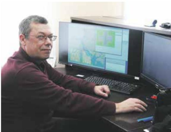
Это центральный пульт управления светофорными объектами. На мониторе в реальном времени видно, как работают все светофоры города. У инженера-диспетчера Сергея Исаченко (на фото) есть возможность удаленно изменять режим работы светофоров, видеть неисправности и оперативно реагировать в случае аварийного отключения
