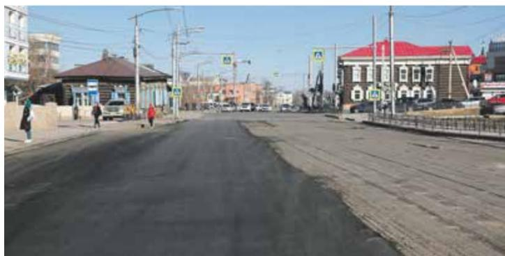
Утро 28 апреля, четверг. Сотрудники «ИркутскАвтодора» уже сняли старый асфальт (4200 квадратных метров) на улице 3 Июля и уложили новый — пока на правую полосу. Прямо с асфальтобетонного завода машины привезут следующую порцию горячей смеси для левой полосы, и этот участок станет как новенький
