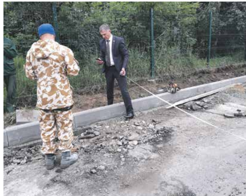
Идет контрольная проверка выполнения работ по реконструкции дороги от бульвара Рябикова, 1а, вдоль гаражного кооператива к детскому саду № 77, школе № 28 и коррекционной школе. Раньше здесь была старая гравийная дорога
