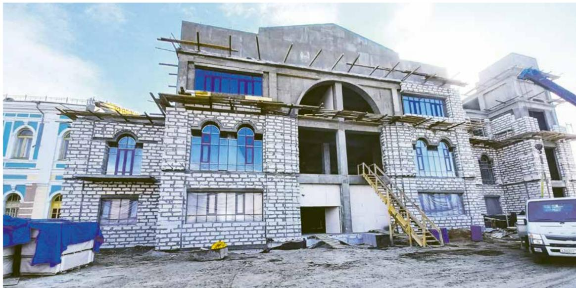
Стройка нового вокзального комплекса в самом разгаре. В марте поставщики привезли материалы для устройства кровли. Беспокоящие критиков пеноблоки покроют слоем штукатурки и покрасят в тот же цвет, что и историческое здание. Через несколько лет никто и не вспомнит, из какого материала сделаны стены. Планируется, что здание введут в эксплуатацию в конце 2022 года
