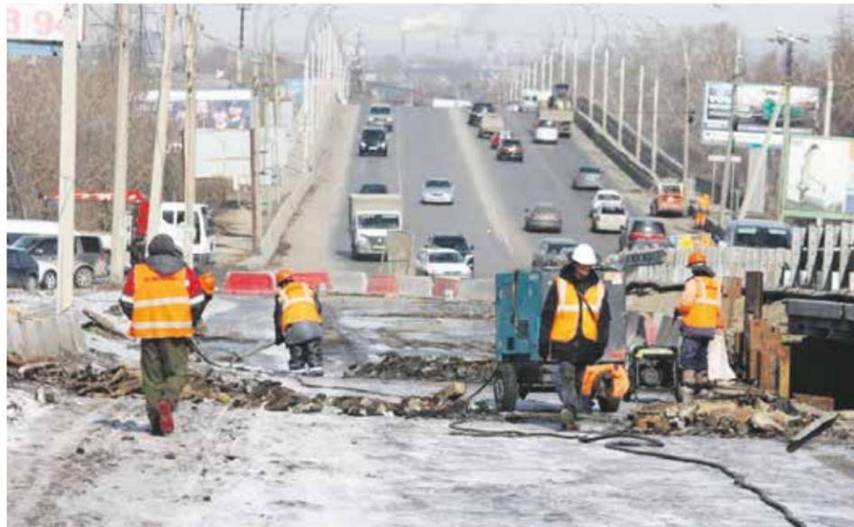
Суббота, 19 марта, выходной день. Но не для тех, кто работает на реконструкции второй части путепровода на улице Джембула. Рабочие проводят демонтаж деформационных швов, затем начнут разбор железобетонных конструкций. В итоге, как и на первой половине путепровода, здесь будут усилены опорные колонны, создан новый металлический каркас, расширена проезжая часть, заменены ограждения, сделано освещение
