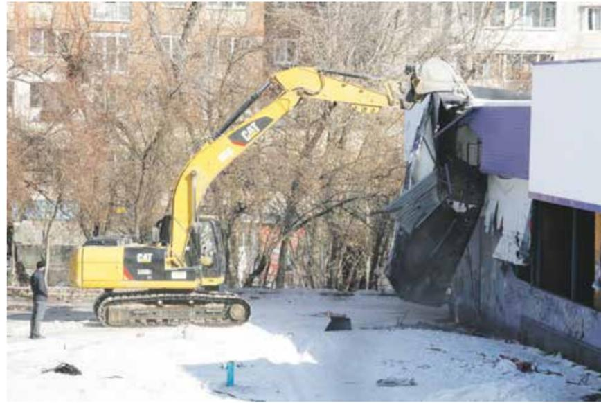
Перед сносом здание бывшего кинотеатра обследовали, сделали экспертизу, подготовили проектную документацию по демонтажу. И сейчас приступили к подготовительным работам — убирают все, что можно убрать вручную. Только потом в работу включатся машины. На этой неделе ковш экскаватора «погрыз» лишь один край здания — рабочие протестировали технику. Основное обрушение железобетонных строительных конструкций будет производиться на следующей неделе с помощью экскаватора с гидромолотом
