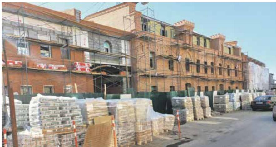
Благодаря технологии теплого строительного контура воссоздание Курбатовских бань идет круглый год. Уже многое сделано: закончены бетонные, гидроизоляционные работы, провели электричество и тепло. Кирпичная кладка готова более чем наполовину. В августе начнется благоустройство территории бань
