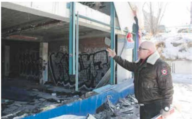
Заместитель генерального директора АО «УКС города Иркутска» Максим Курин объясняет, как сделано здание: на железобетонных колоннах лежат плиты перекрытия, на плитах — утеплитель и покрытие профлистом, а стены — сэндвич-панели. Эти перекрытия также будут разбирать с помощью экскаваторов. Есть здесь и цокольный этаж, который также демонтируют и засыпят грунтом. Окончательно здание бывшего кинотеатра будет демонтировано к 1 мая
