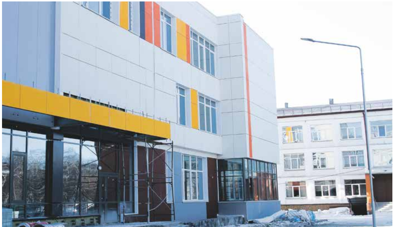
Новый корпус начальной школы – это автономное здание, которое построено на месте бывшего хоккейного корта рядом с основным зданием СОШ № 14 (на фото справа). Младшие школьники перейдут в современный учебный блок, а старшеклассники благодаря этому смогут заниматься в одну смену
