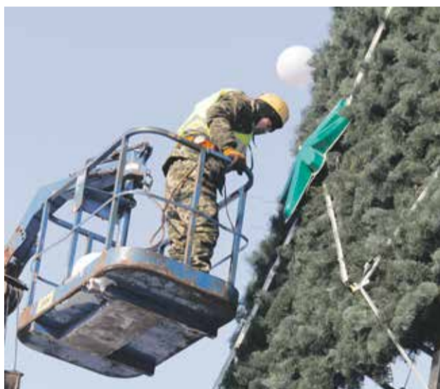
Новогодняя иркутская красавица относится к каркасному типу искусственных деревьев и поэтому очень крепкая. Собирается и разбирается сложно: в ней много элементов, болтовых соединений и иллюминации. И каждый раз трудиться монтажникам приходится на высоте пятиэтажного дома
