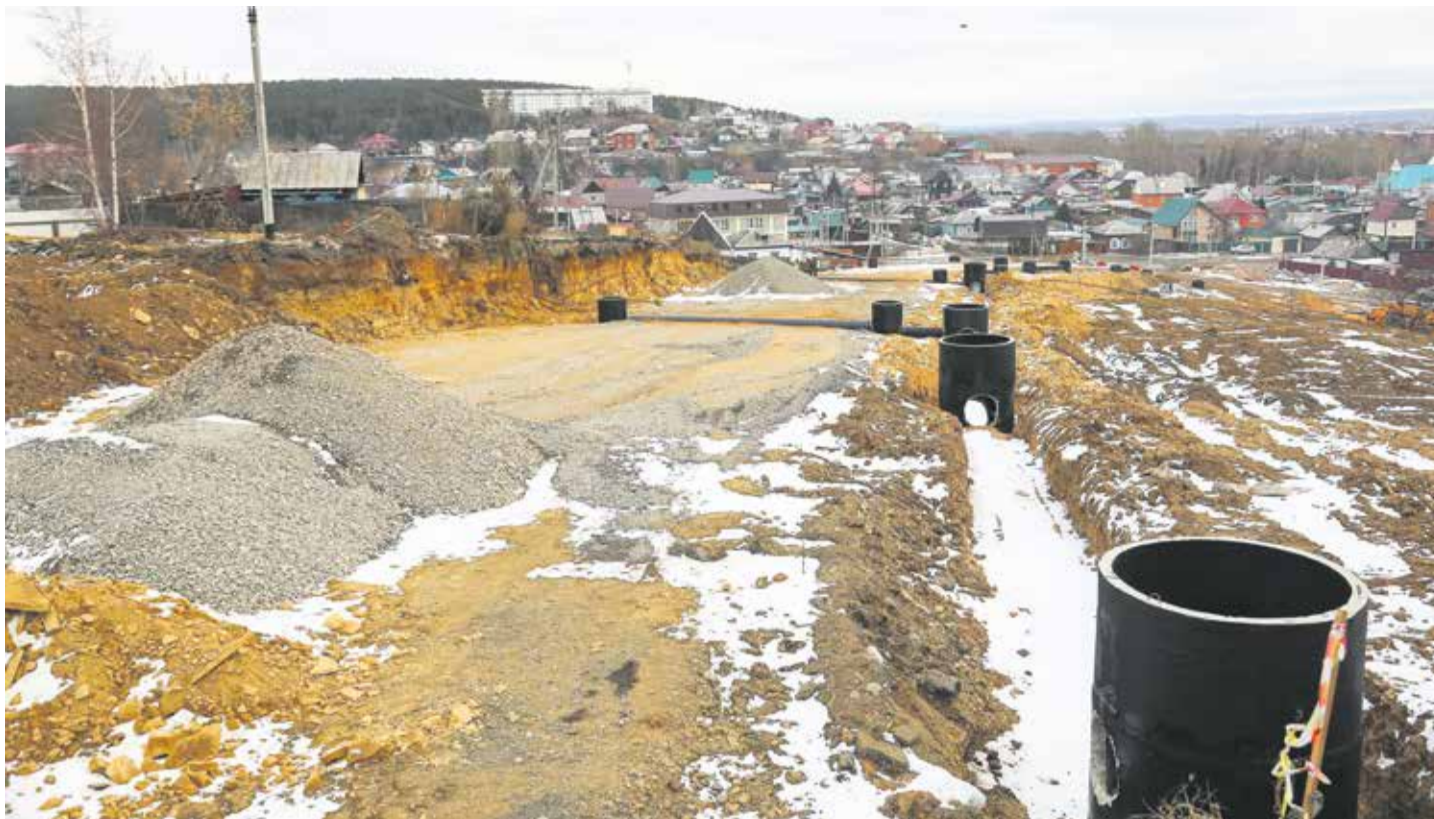
Реконструкция улицы Карбышева — один из ключевых наказов, которые жители предместья Рабочего дали своему депутату Алексею Распутину несколько лет назад. После завершения строительства они получат широкую безопасную дорогу вместо крутого аварийного участка
