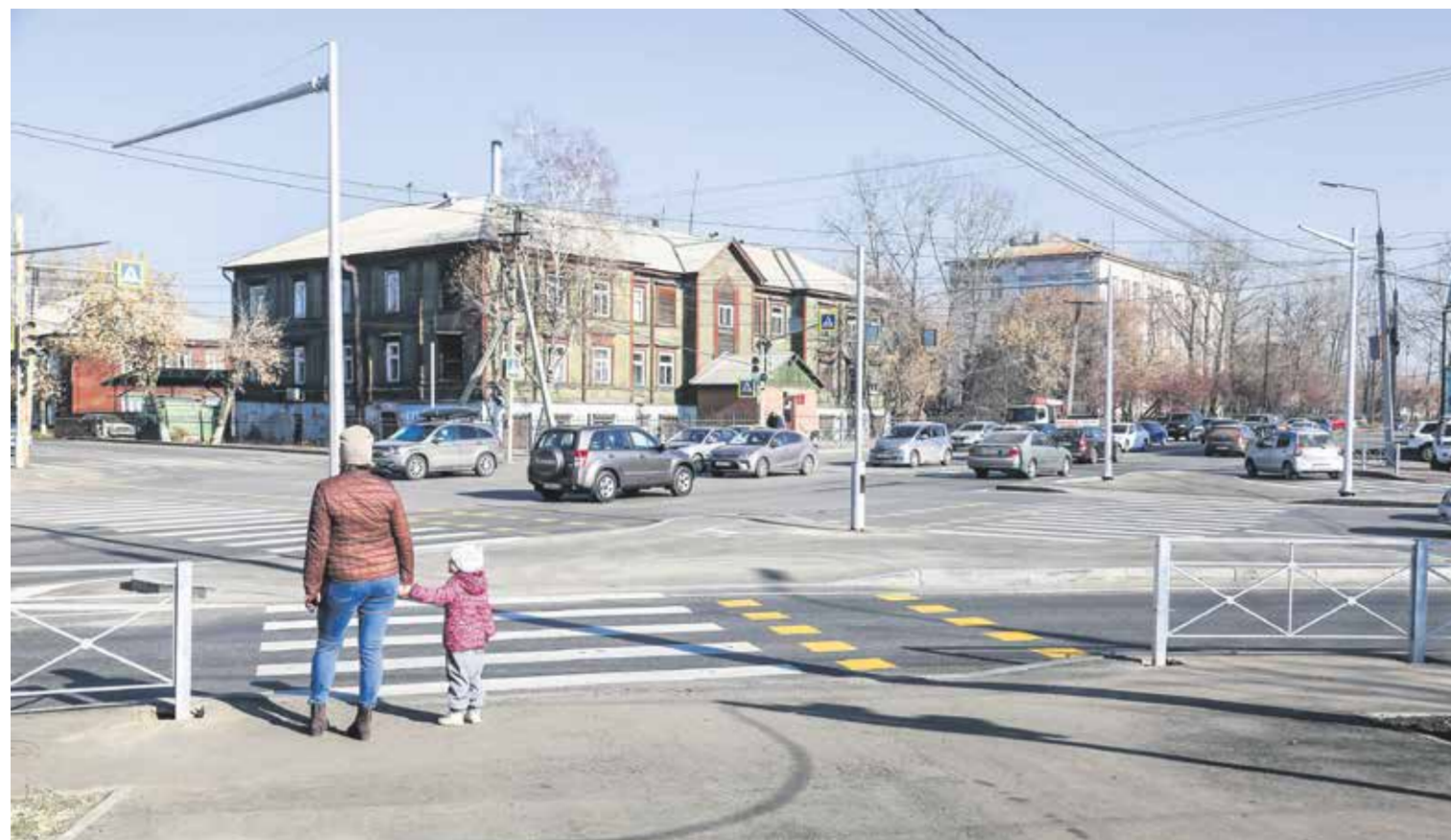
Перекресток улиц Баррикад и Ушаковской не узнать: дорожники обустроили здесь островок безопасности, установили ограждения, дорожные знаки и светофоры. На Баррикад появились новые тротуары, во время ремонта были расширены перекрестки, сделаны дополнительные парковочные карманы, смонтировано современное светодиодное освещение
