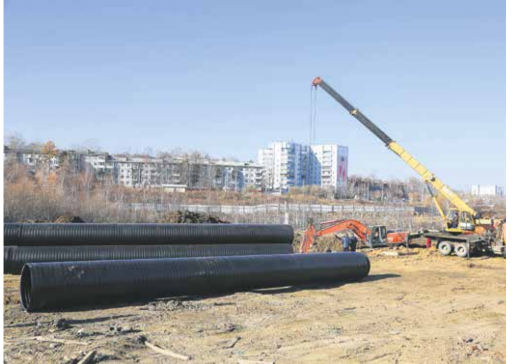
Эти огромные трубы нужны для отвода реки Большой Кузьмихи, которая протекает под будущей школой на улице Багратиона. В проекте предусмотрено немало таких сложных решений, поэтому и стоимость объекта соответствующая — 1,4 млрд рублей
