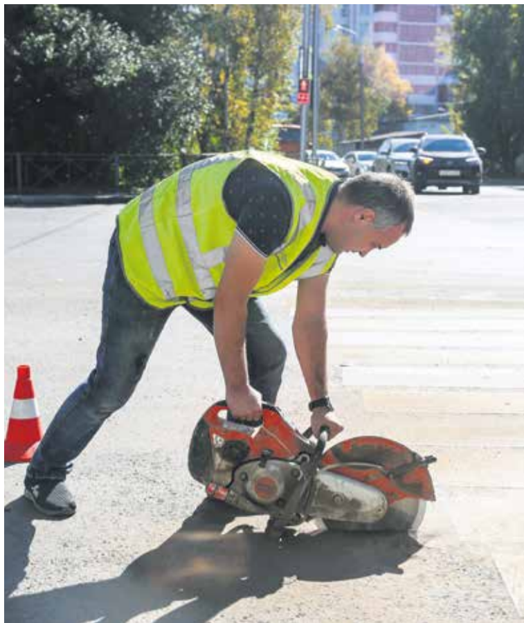
Перекресток Пискунова и Красноярской. Здесь совсем недавно разрыли дорогу, чтобы отремонтировать трубы под землей. Сейчас дорога восстановлена. Но достаточно ли качественно? Чтобы проверить это, сотрудник Иркутского испытательного центра Михаил Маргелов провел вырубку образцов верхнего и нижнего слоев асфальта
