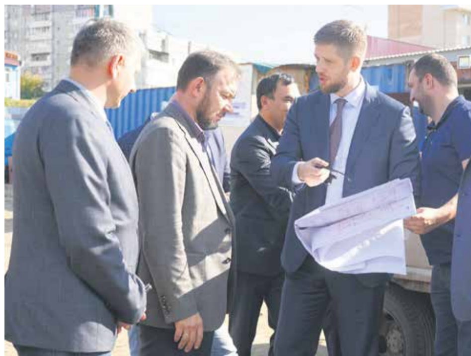
Идет обсуждение строительства катка в Пади Долгой. До конца декабря он должен быть готов на 80 %. А в 2022 году, если все сложится удачно, начнут формировать общественное пространство рядом с ним
