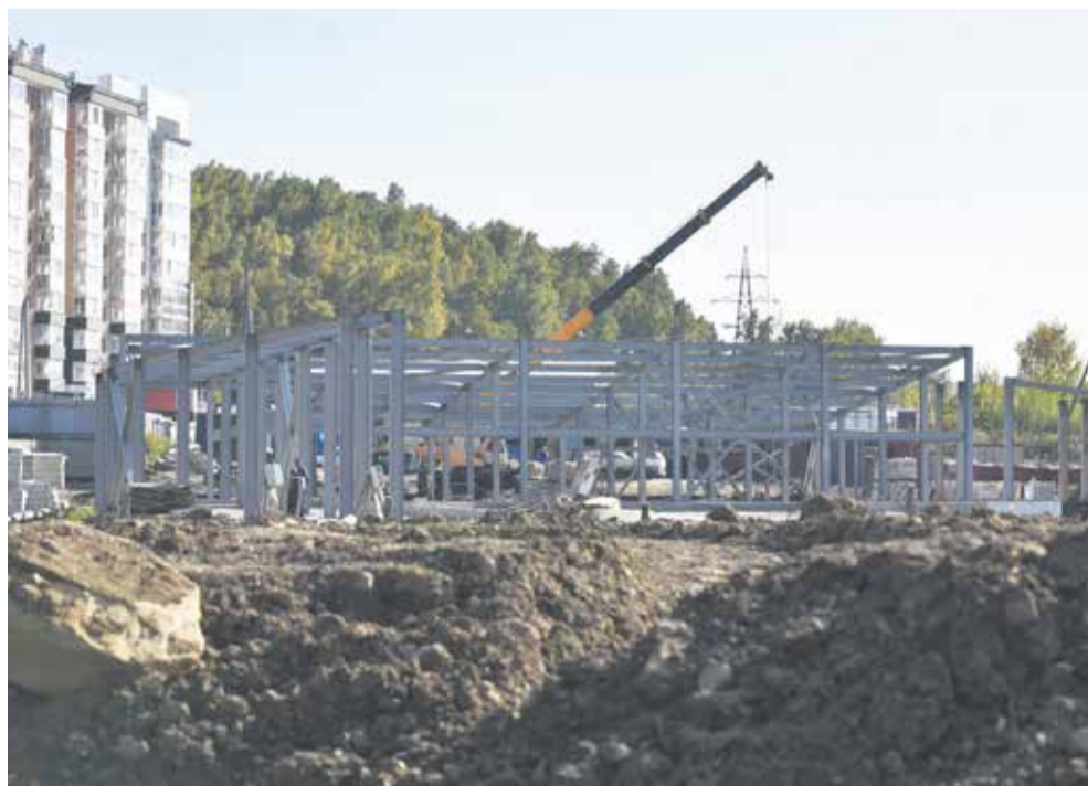
На фото — каркас будущего катка. Вот-вот начнется установка сэндвич-панелей, к концу октября планируют смонтировать тепловой контур здания
