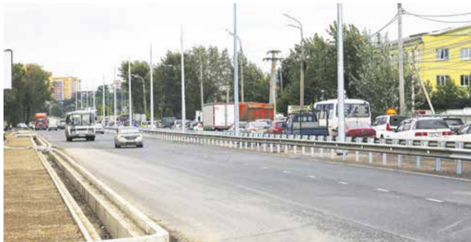
А это Тракторная, которую расширят до шести полос уже в этом году. Две из них будут выделены для общественного транспорта — впервые в Иркутске. Все это позволит избежать пробок; также будет расширена проезжая часть Иркутского моста с четырех до шести полос (его ремонт планируют закончить в 2022 году, то есть с опережением графика на несколько месяцев)
