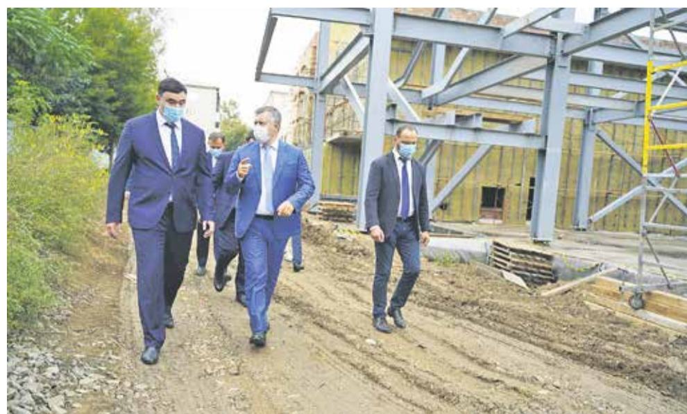
Строительство нового блока начальной школы №14 в Октябрьском районе идет под личным контролем губернатора Игоря Кобзева
