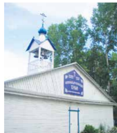
У Александро-Невского храма, который действует в Иркутске с 1999 года, очень непростая судьба. Здание, которое выделили под эту церковь, находилось в аварийном состоянии, здесь случилось несколько пожаров. Его поднимали из руин на пожертвования местных жителей, которые сами и ремонтировали приход. Денег не было даже на колокола, поэтому первое время их заменяли обеззвонными кислородными баллонами. Сейчас здесь не только проводятся службы, но и работает воскресная школа для взрослых и детей
