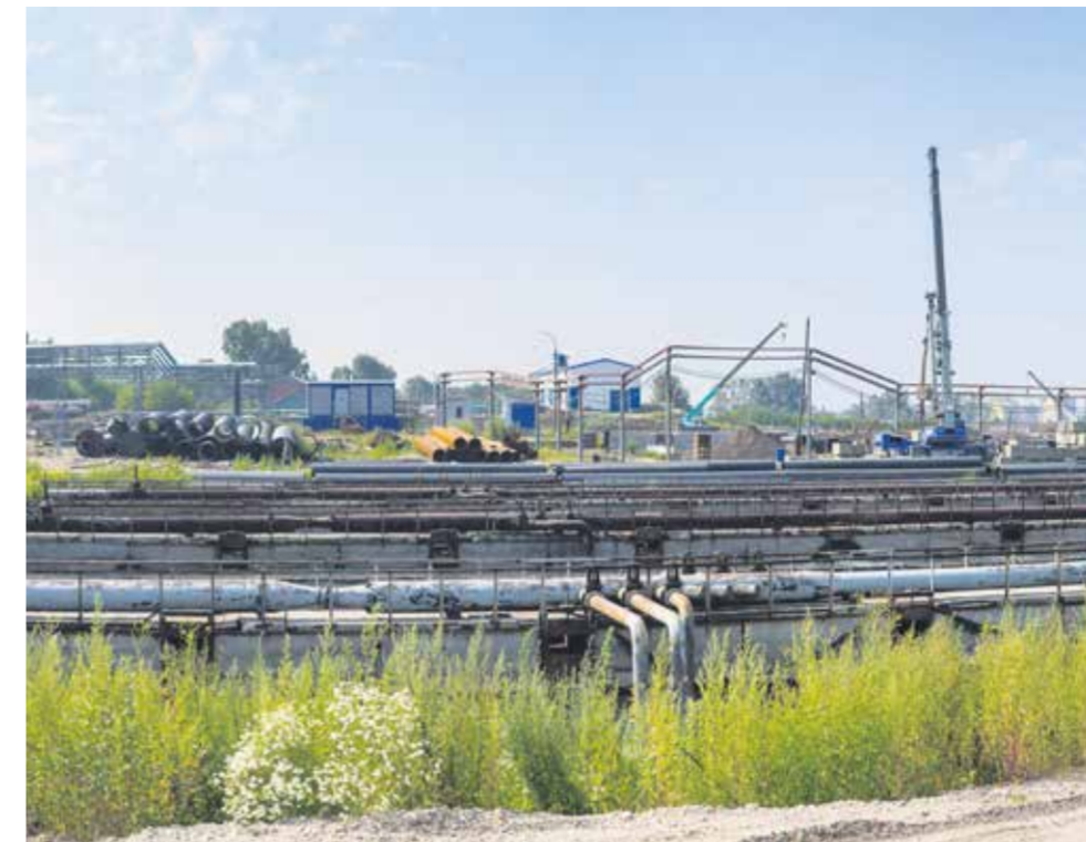
А так выглядят аэротенки, построенные в начале 90-х годов — почувствуйте разницу. Очень скоро отслужившие свой срок сооружения будут демонтированы, а на их месте вырастут новые, современные, экологичные
