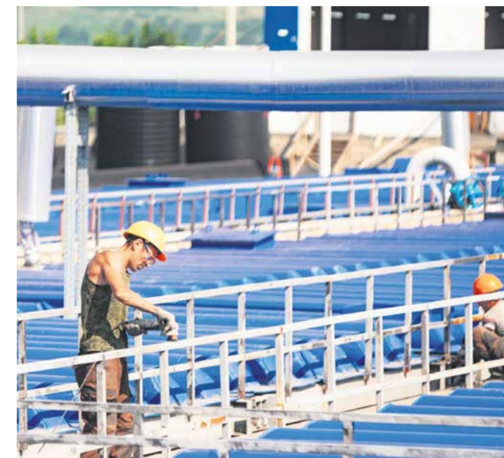
Строительные работы не прекращаются ни на минуту. Подрядчик — «Первая строительная компания»
