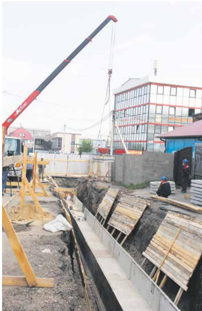
15 июля на улице Красноярской начали строительномонтажные работы на тепловой сети. Трубы с полимерной изоляцией, которые вскоре уложат в этот лоток, способны выдержать сильное гидродавление, а срок их службы свыше 30 лет. Все это позволит не только увеличить надежность теплоцентралей, но и подключить новых потребителей
